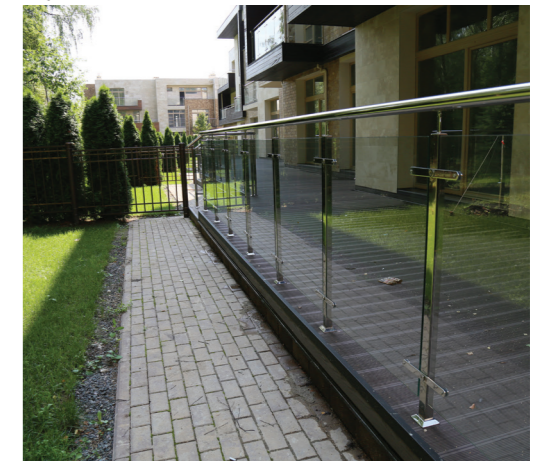
Ограждение террасы со стойками k749, прозрачным стеклом 10 мм и поручнем Ø50,8мм из нержавеющей стали.
