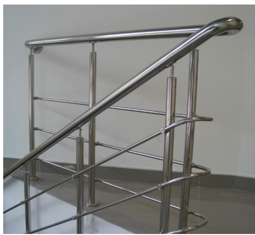
Ограждение лестницы и площадки со стойками k713, с тремя ригелями и поручнем Ø50,8мм из нержавеющей стали.
