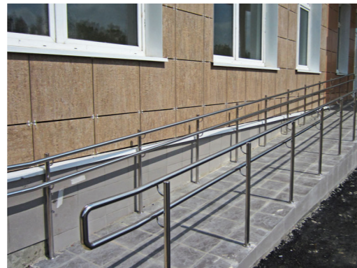
Ограждение пандуса поликлиники со стойками к750 и двойным поручнем Ø38мм из нержавеющей стали.
