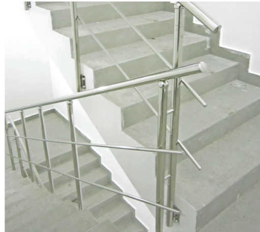
Выбор профессионалов: ограждения со стойками к703 с торцевым креплением и 2-мя ригелями - сварная конструкция. Благодаря готовым стойкам, скорость монтажа возрастает в 3 раза.
